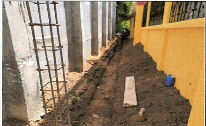
Foto 2: Se esta realizando el mejoramiento a muro perimetral
