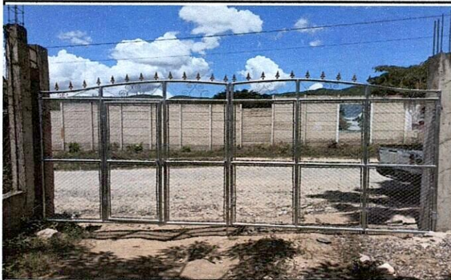
Foto 1: Se esta realizando el mejoramiento a portón de ingreso
