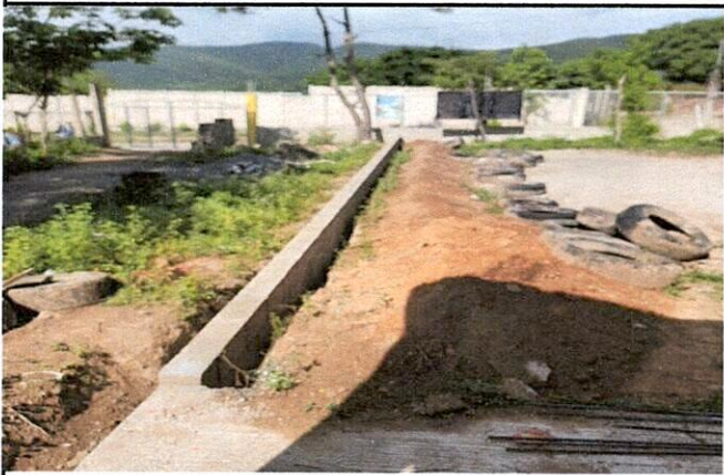
Foto 3: Se esta realizando el mejoramiento muro de contención
